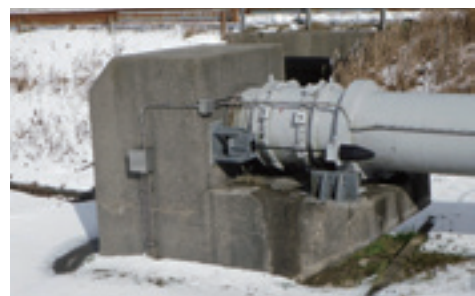
写真-1 落橋防止構造 (現地調査事例)
