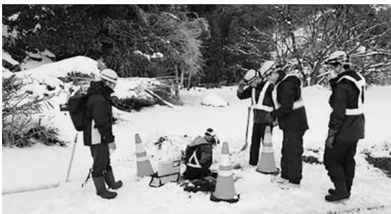
水道管の応急復旧（上）、下水道管の調査（下）
