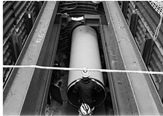
犬山系導水路E管の更新（鋼管によるPIP工法）
