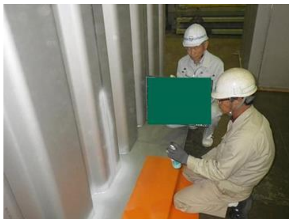
写真2 浸透探傷検査実施状況
