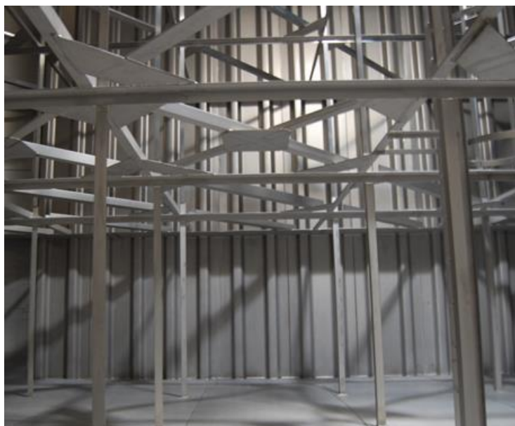
写真 1 ステンレス鋼製角形配水池内部構造
