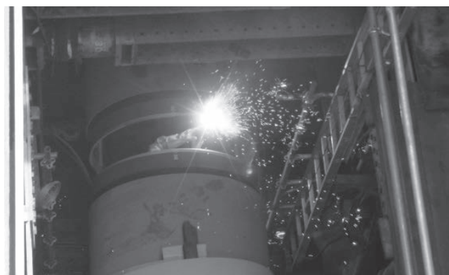
写真3 水道用推進鋼管通水本管溶接状況
