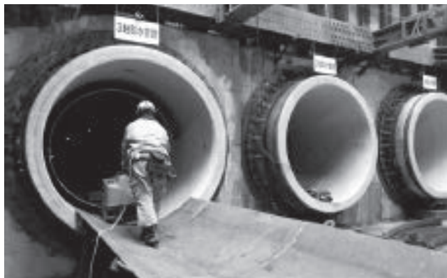
写真1 さや管工法 (推進管内に水輸送用鋼管を持ち込む状況)
