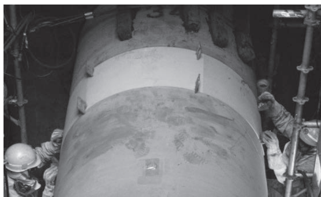
写真4 水道用推進鋼管外装管継輪設置状況 (Ⅰ型)
