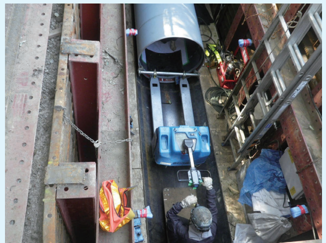
巻き込み鋼管挿入状況
