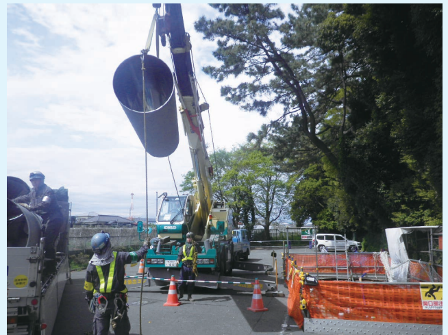
吊り込み状況
