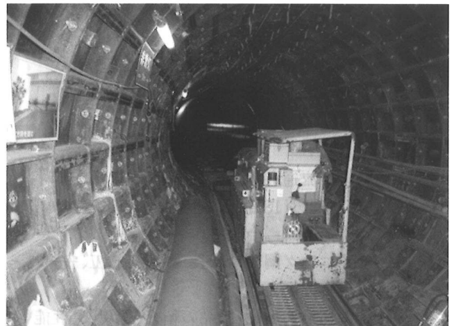
④鋼管の搬入
