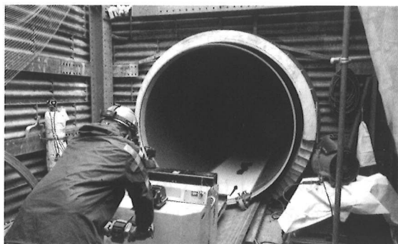
写真 PIP工法の施工状況
