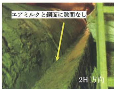
写真2 上部の鋼面状況 (発錆なし)
