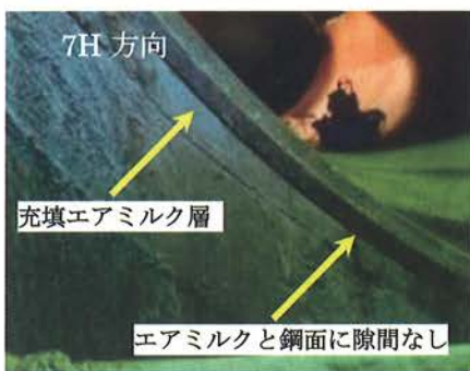
写真3 エアミルクの充填状況
