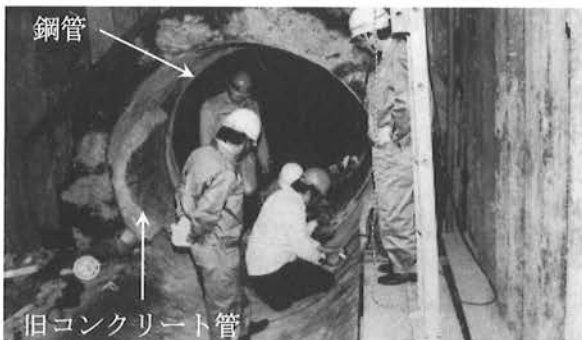
写真1 鋼管による更新工事施工状況 (昭和62年)
