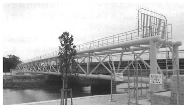
写真-4 トラス補剛形式
