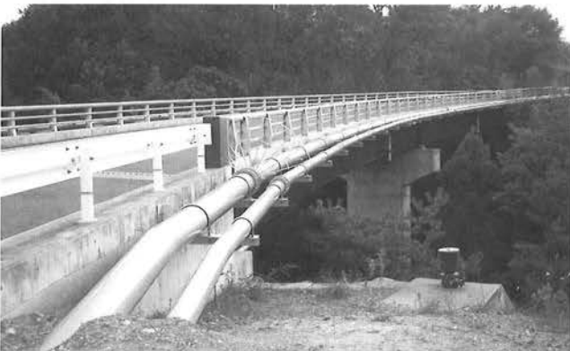
写真-6 橋梁添架形式
