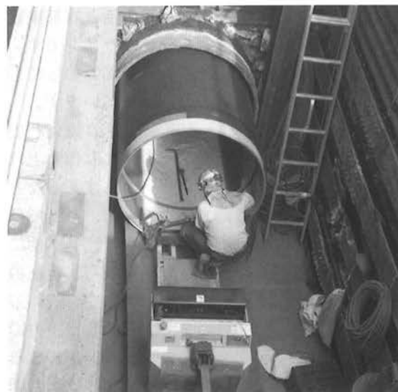
パイプ・イン・パイプ工法の施工状況
