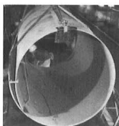
写真-2 巻込鋼管
