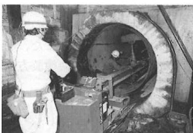
写真-1 鋼管挿入状況
