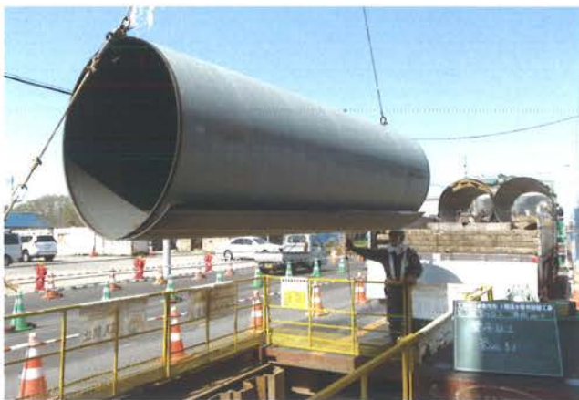
吊り込み状況
