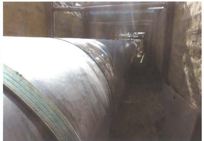
開削工事で布設
