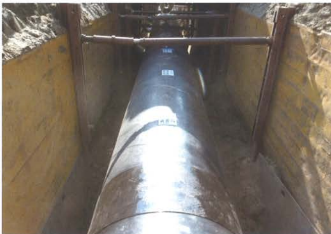
開削工事で布設
