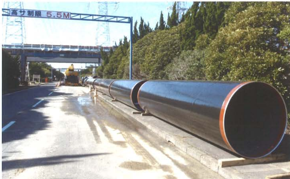
配管工 1350mm×12t×900m
