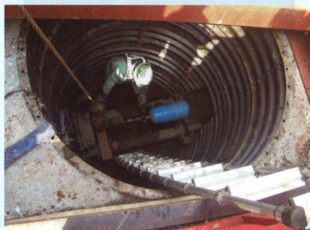
SDF管の引込み完了【到達立坑】
