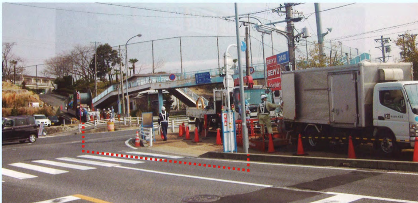
国道19号線を遮断せず昼間の施工が可能
