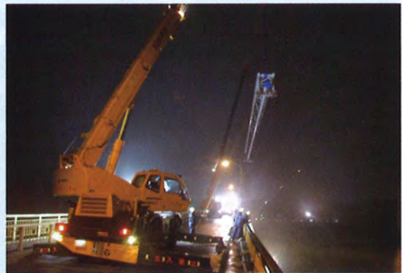
25tラフタークレーン2台による相吊架設
