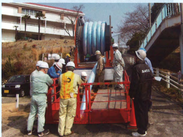
引込み作業の状況【発進立坑】
