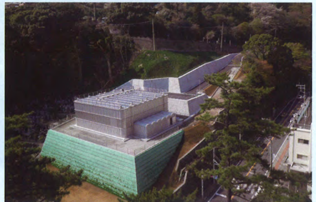
施工後の配水池
