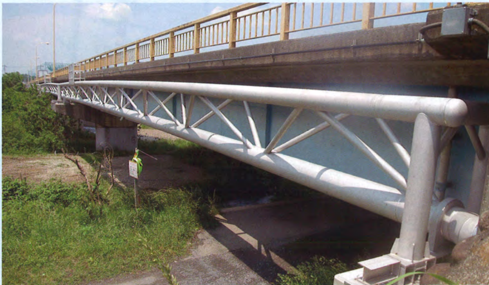
完成した水管橋の全景
