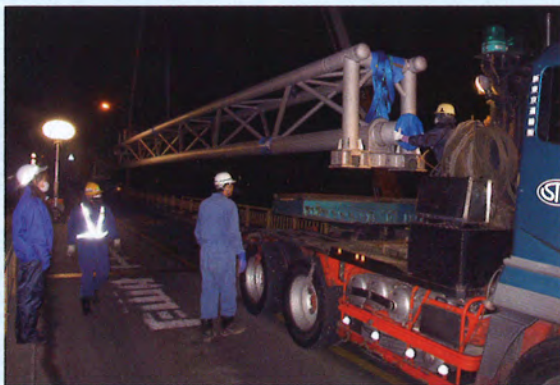
ポールトレーラーでの横持移動
