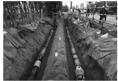
写真-1 埋設状況
