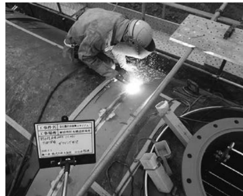
写真-2 本溶接(外面)
