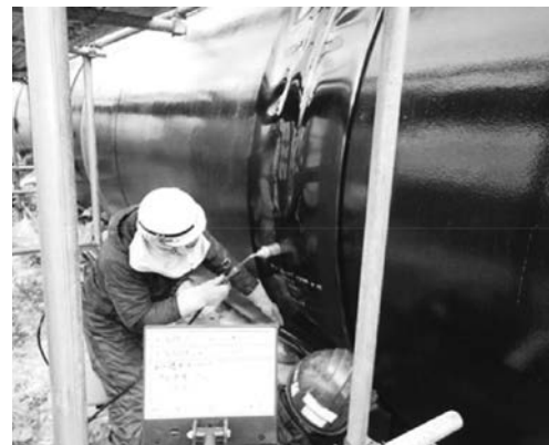
写真-3 外面被覆(ジョイントコート)
