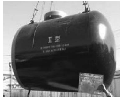
写真-1 貯水槽本体の吊り降ろし
