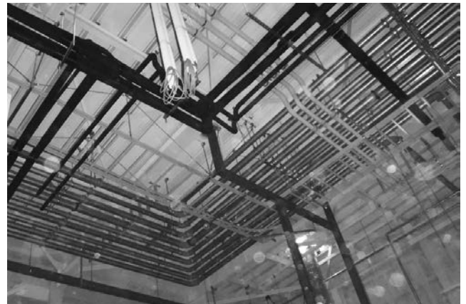
写真-5 現場配管組立・設置完了
