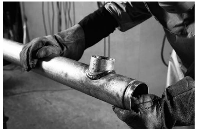
写真-4 穴あけと溶接
