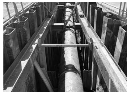
愛知県営工業用水道で布設した鋼管
