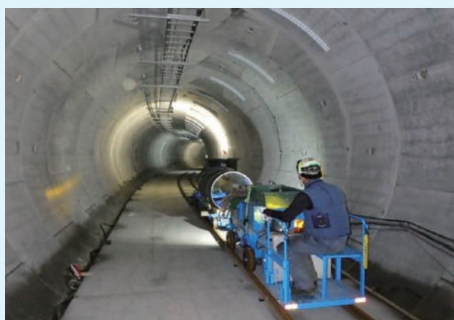
材料運搬状況
