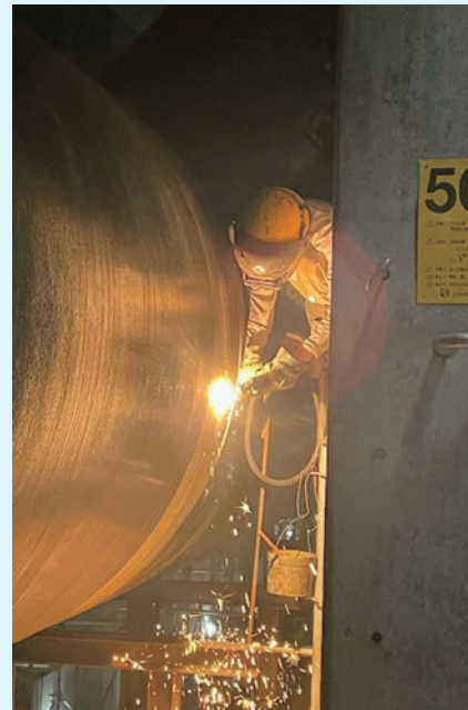
外面溶接状況
