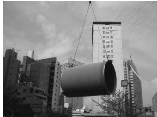
写真-1 鋼管の吊り降ろし
