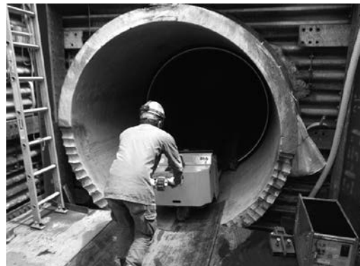
写真-2 鋼管の運搬
