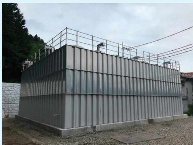
配水池完成時
