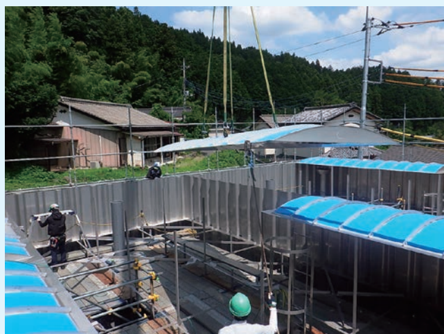
屋根板の据付状況
