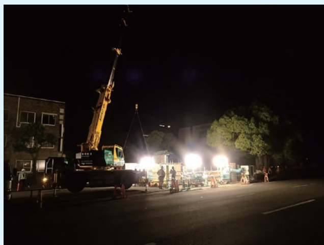
鋼管吊り込み
