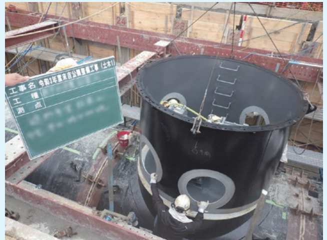
遮断弁室据付
