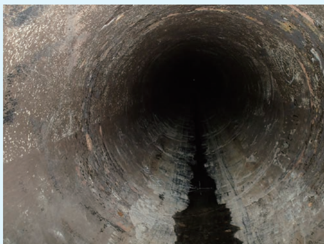
既設管 着工前
