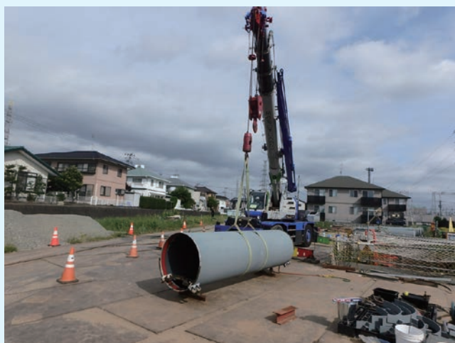
鋼管吊り降ろし状況
