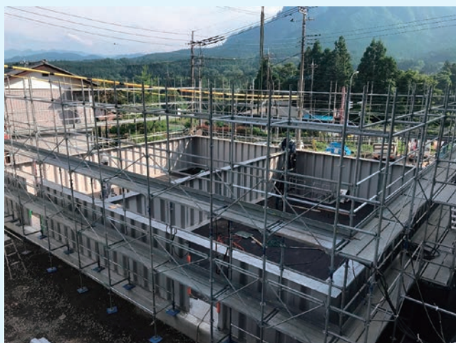
配水池側板据付状況
