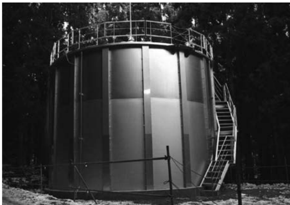
写真－2 円筒形配水池の施工例
