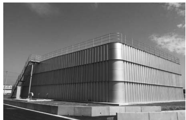
写真-4 角形配水池
