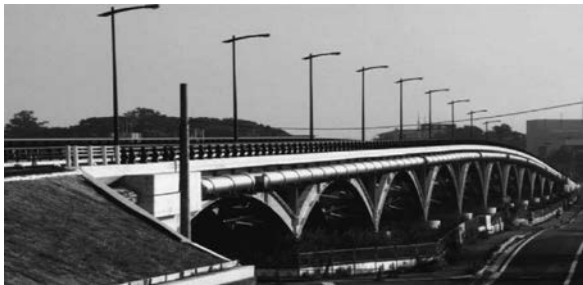
写真－1 添架形式水管橋の施工例
