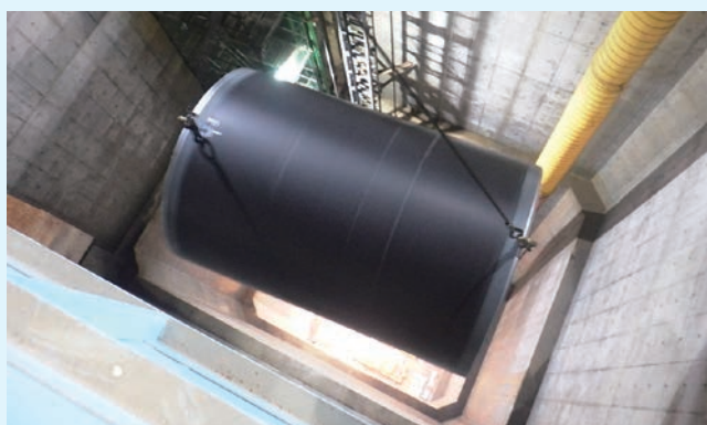
鋼管吊り降ろし状況
