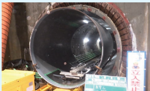
鋼管運搬状況
