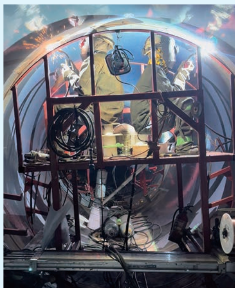
鋼管溶接状況
