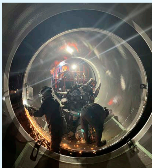
鋼管開先加工状況
