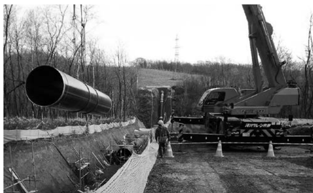
鋼管による農業用パイプラインの構築
