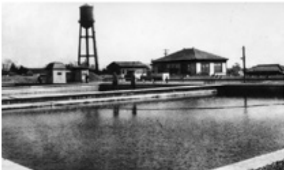
川崎水道の始まりである戸手浄水場
