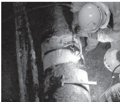
写真1 A-1被害状況
