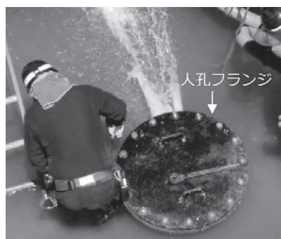
写真4 A-4被害状況
