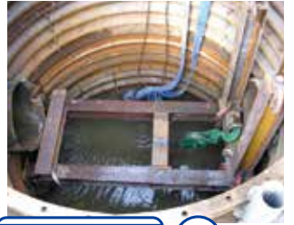
引込み設備設置
