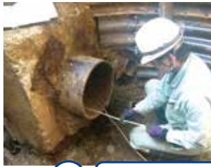
既設管延長測定
