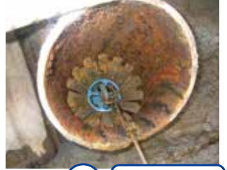
既設管内清掃
