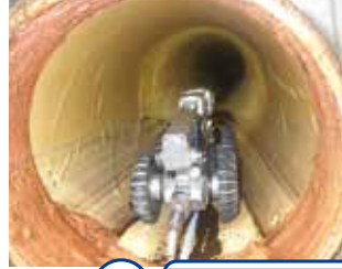
管内カメラ調査
